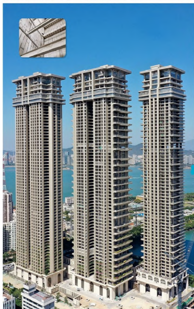
Costruzioni residenziali di lusso in acciaio e pannello sandwich eps/cemento da 100 mm e da 150 mm
