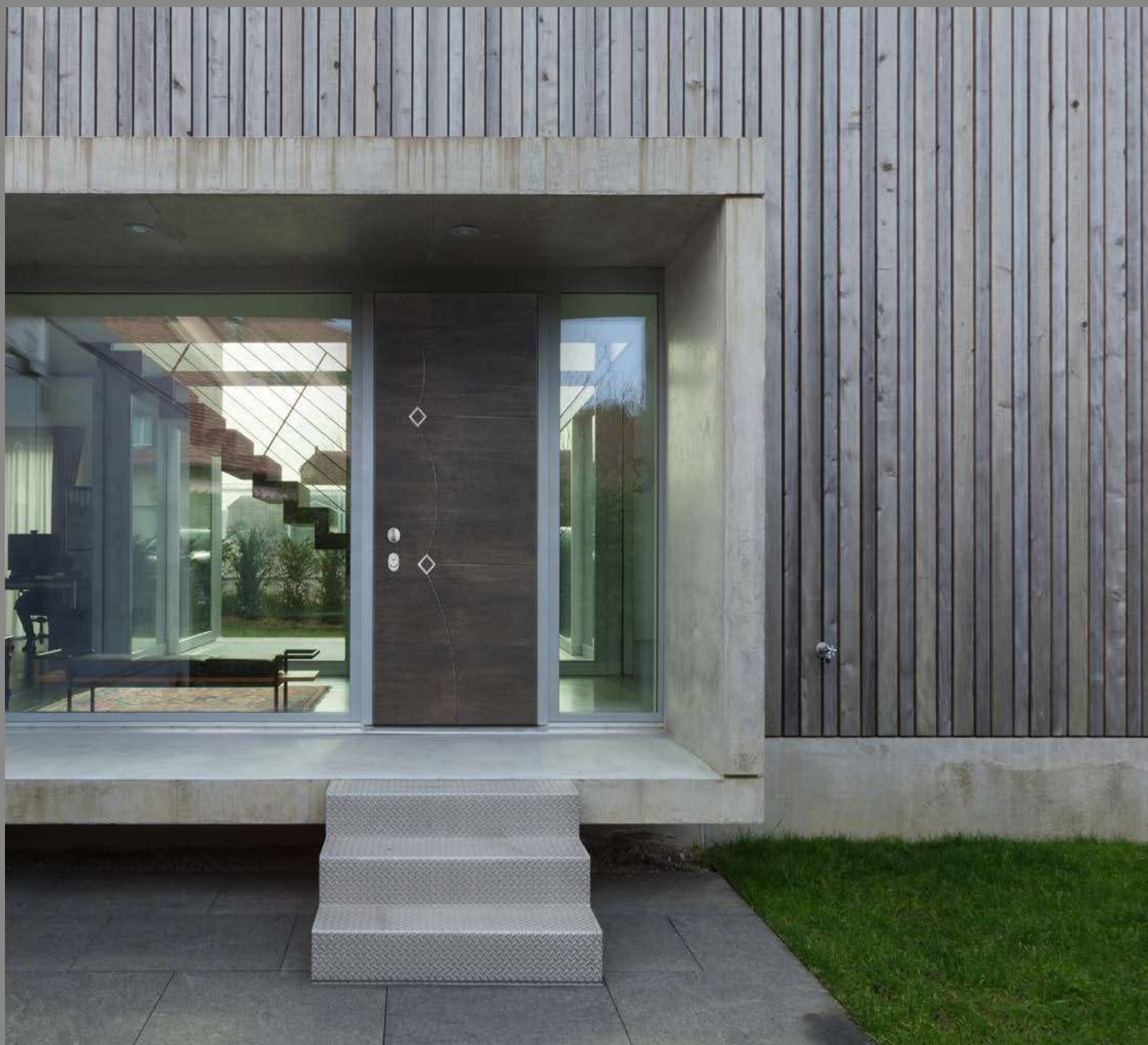
RIVESTIMENTO ESTERNO MODELLO ARABIC Multistrato rovere orizzontale tinto anice con inserti in acciaio Esposizione agli agenti atmosferici consigliata limitata
